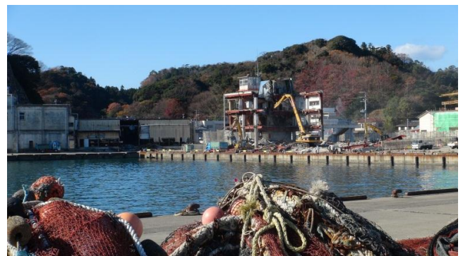
取り壊される建物
